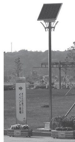
きらら公園で開催された「植樹祭」時に設置した太陽光発電式LED街灯
