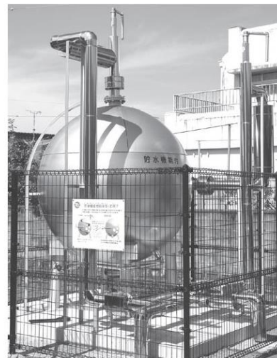
小学校に設置された貯水機能付給水管
