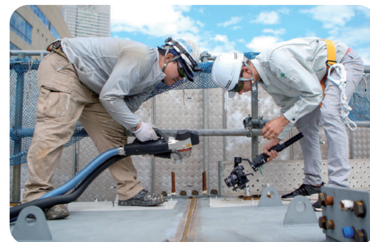
レーザークリーニング装置での作業様子
