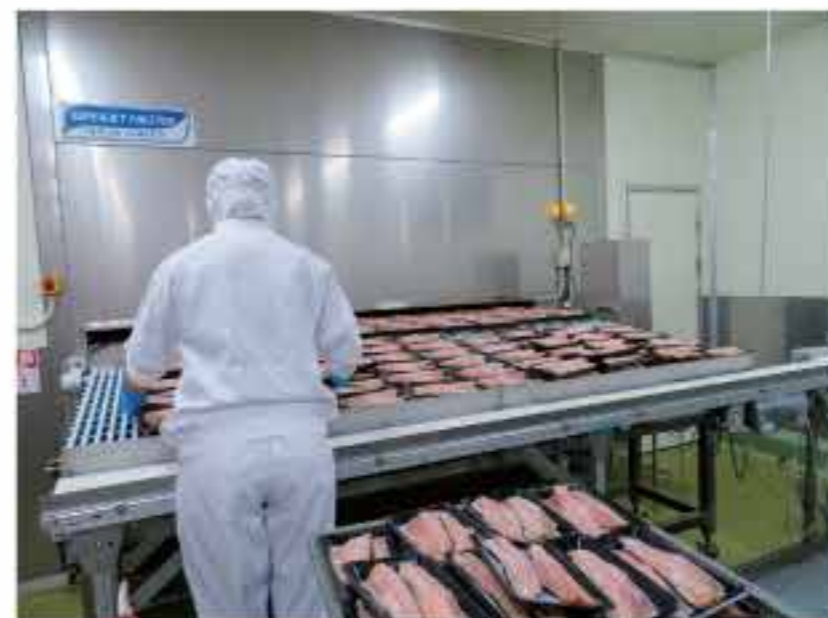
フリーザー これにより製品を連続的に急速冷凍できるようになった。
