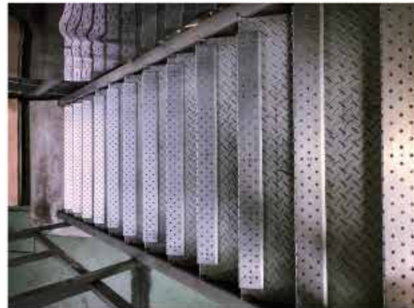
くつ底キャッチャーを取り付けた階段
