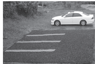
玉砂利固定化用具の施工事例
