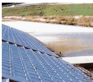
河川護岸を守る 「張ブロック」
