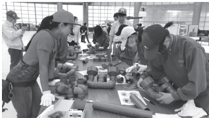
ビニール管加工体験 (山口県管工事工業協同組合)
